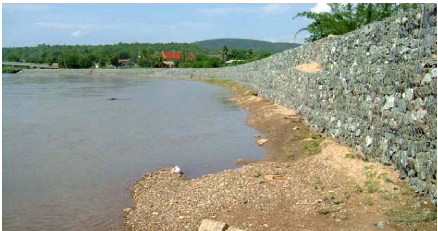
รูปที่ 2 เขื่อนป้องกันตลิ่งริมแม่น้ำปิง บริเวณบ้านหนองมะจับ ต.แม่แฝก อ.สันทราย จ.เชียงใหม่
