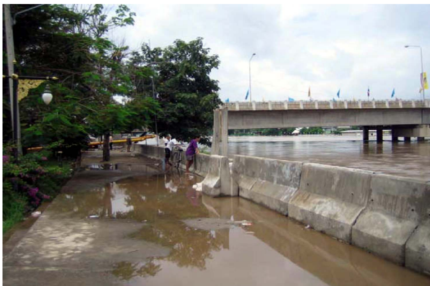
รูปที่ 3-18 คันป้องกันน้ำท่วมกึ่งถาวร แบบแผงคอนกรีตสำเร็จ ณ บันไดทางลงแม่น้ำหน้า จ.อ่างทอง
