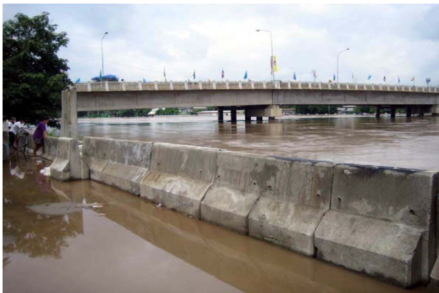
รูปที่ 3-17 คันป้องกันน้ำท่วมกึ่งถาวร แบบแผงคอนกรีตสำเร็จ ณ บันไดทางลงแม่น้ำหน้า จ.อ่างทอง
