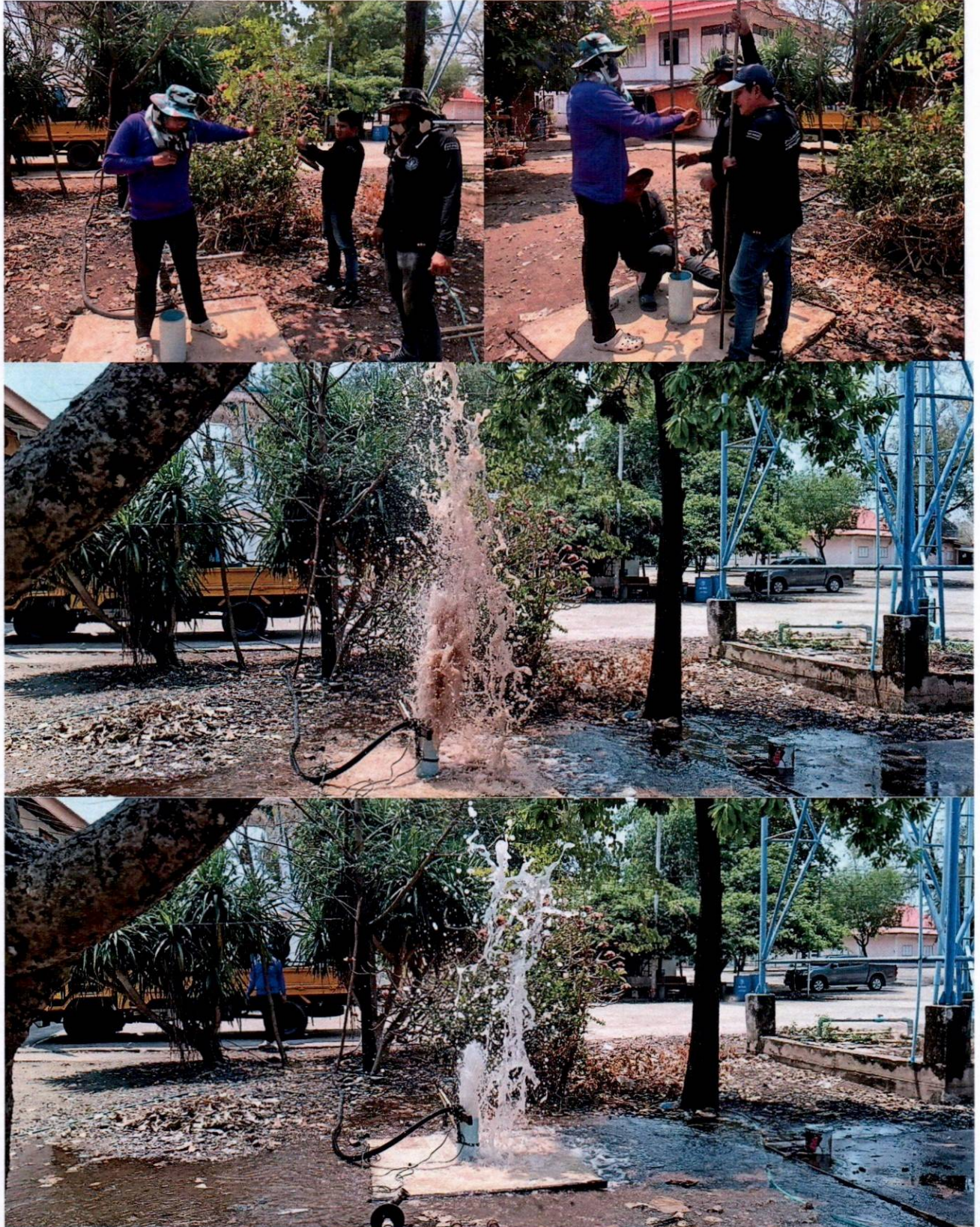
ระบบประปาวัดคอนไซโย หมู่บ้านคลังเงิน หมู่ที่ ๑๓
